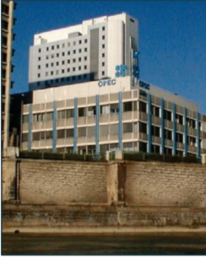
▲ مبنى منظمة أوبك في فيينا
